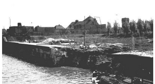
Abb. 7: Bombenschaden an der südlichen Schleusenkammer.
