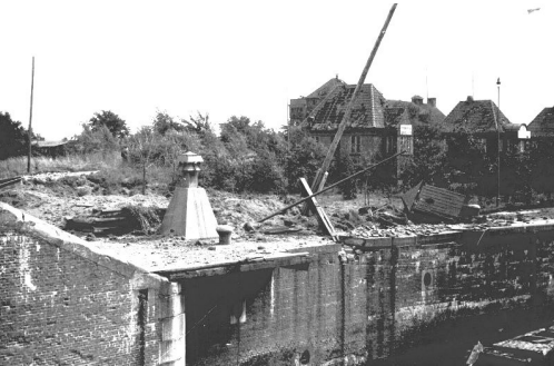
Abb. 3: Bombenschäden im Bereich der südlichen kanalseitigen Torkammer.
