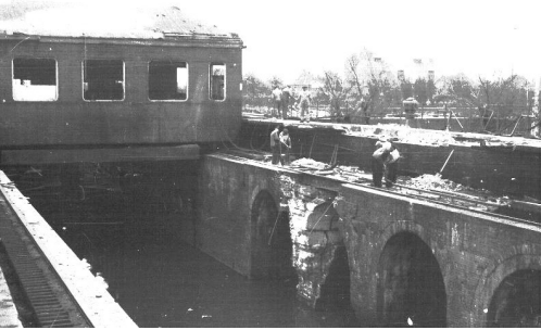
Abb. 2: Bombenschaden an der südlichen kanalseitigen Torkammer.
