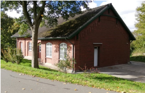
Abb. 43: verbliebenes Maschinenhaus in Kudensee.
