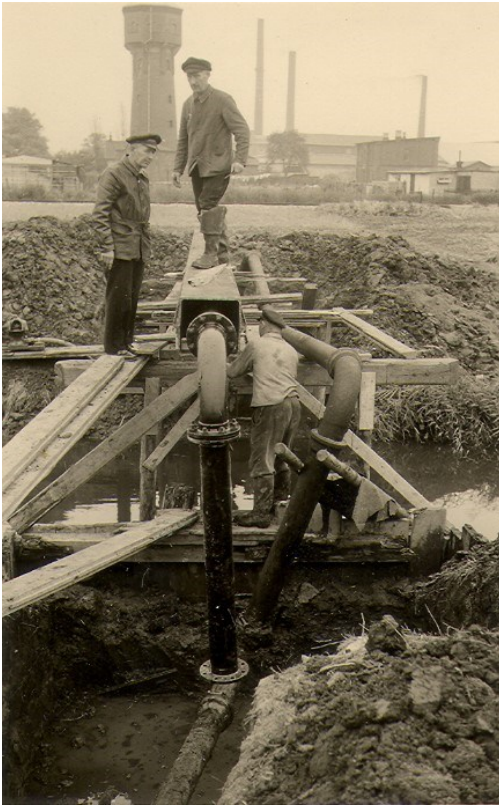
Abb. 33: Wasserleitungsarbeiten auf der Südseite in späterer Zeit.
