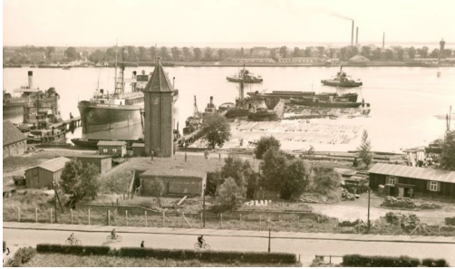
Abb. 31: WSA- Betriebshafen mit Wasserturm.
