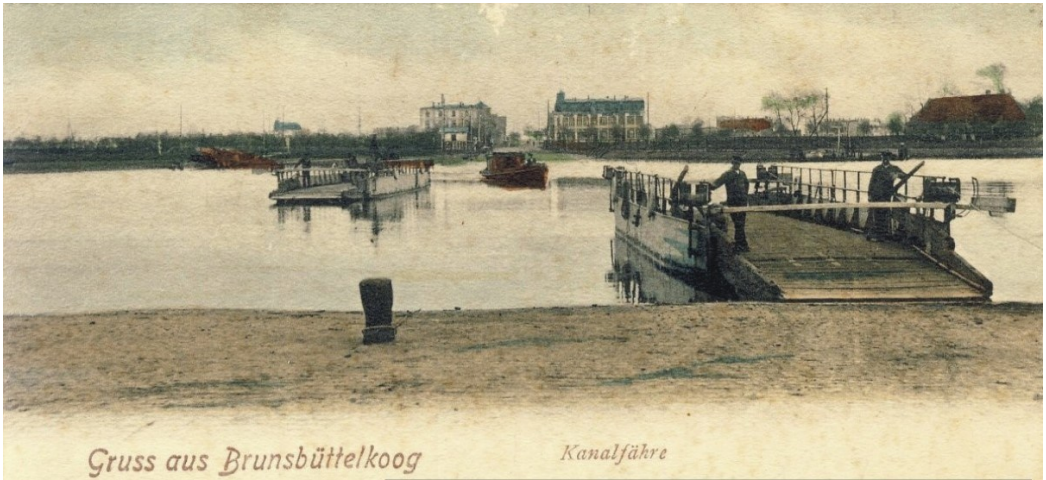
Abb. 2: Die erste Kanalfähre im Brunsbüttel-Eddelaker-Koog nach 1895, Blickrichtung Südseite.
