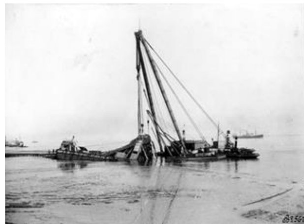
Fortgeschrittener Hebevorgang, steil aufgestellter Hebebock
